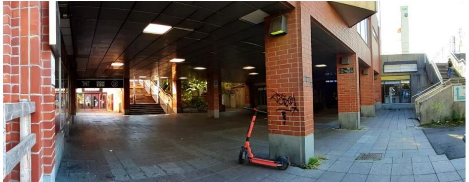
Näkymä suunnittelualan luoteiskulmalta elokuussa 2022. Kuvan taka-alalla vasemmassa laidassa Pendoliino-tunneliin johtava sisäänkäynti, jonka oikealla puolella on Pakkahuoneenaukiolle nousevat portaat. Ratapihankadulle nousevat portaat näkyvät kuvan oikeassa laidassa. (Kuva: Tampereen kaupunki)
